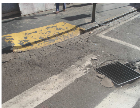
Figura 09 – Erro de Implantação (cruzamento da Rua São Sebastião com José Bonifácio). Fonte: Daniel Gerardi
