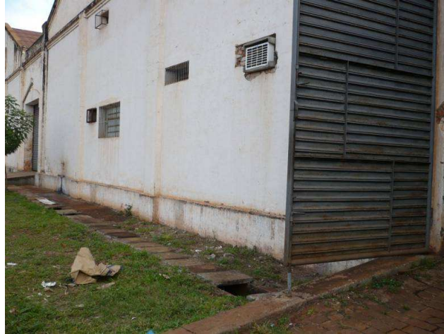
Figura 7: Indicação de uma incorreta tentativa de intervenção nos Galpões de Café. Fonte: Artur Rozestraten, 2008
