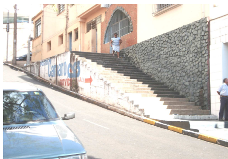
Figura 07 – inclinação e desnível (Rua Rui Barbosa)
