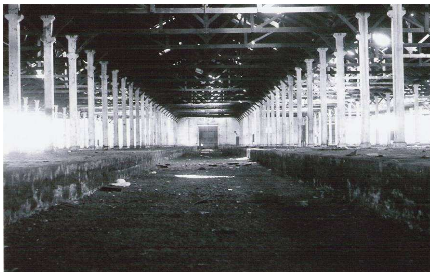
Figura 4: Indicação da situação interna de um dos Galpões de Café da Av. Bandeirantes – cobertura de madeira, 1995.
